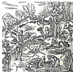
Aufsuchen einzuführender Schichten mit Wünschelrute (A) und Schurfgräben (B); aus den 12 Büchern über Bergbau und Huttenwesen von Georg Agricola (1556).
