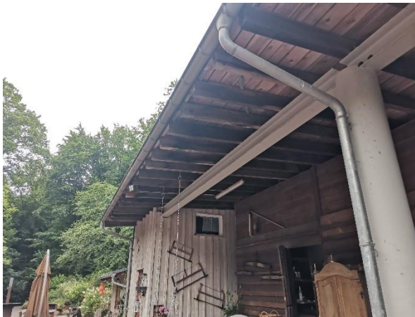
Abb. 4: Blick auf den Dachüberstand der Lagerhalle und die Stützkonstruktion (witterungsgeschützte Nischen/ Simsbereiche vorhanden)
