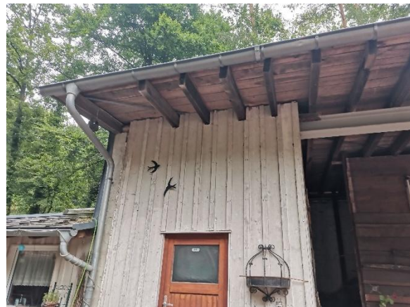
Abb. 4: Nahansicht der Dachunterkonstruktion
