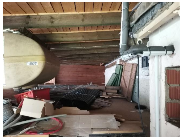
Abb. 7: Weitere Aufnahme von der Holzdecke der Lagerhalle
