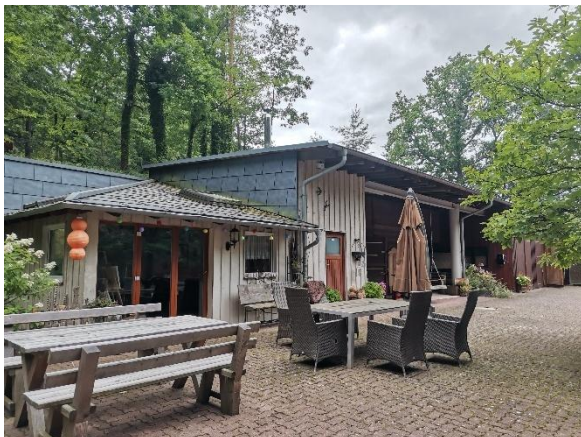
Abb. 2: Blick auf die Lagerhalle, die um 1. Stockwerk mit Nutzungsziel „Wohnnutzung“ aufgestockt werden soll. Links hinter der Halle grenzt hinter einer einreihig von Bäumen bestandenen Böschung auf Dachhöhe der Alte Kirchweg an
